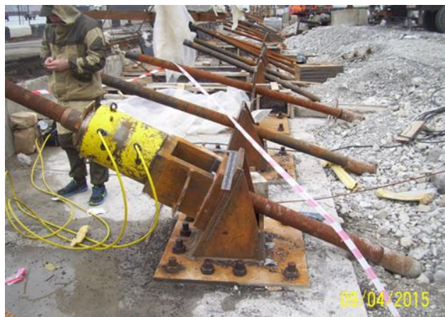
Испытание анкера с использованием проходного домкрата
